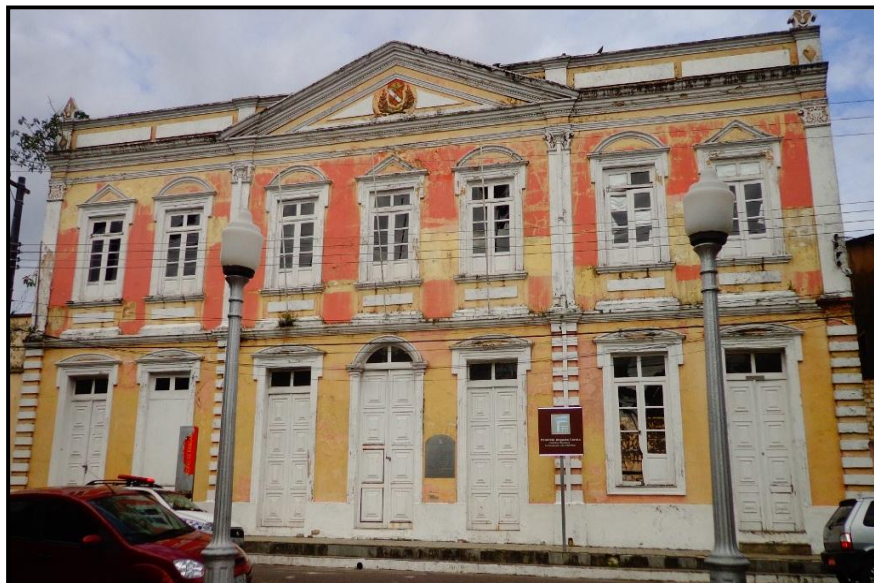
FOTO 18- PALÁCIO AUGUSTO CORRÊA: edificação construída no final do século XIX início do século XX de estilo eclético. Antiga sede da prefeitura de Bragança que atualmente encontra-se interditado devido os riscos de desabamento (Foto: Alessandra Lobato. Trabalho de campo, julho de 2013).
