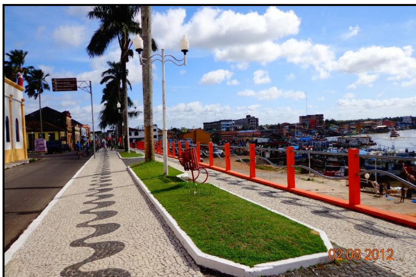
FOTO 15- VISÃO PARCIAL DA AVENIDA VISCONDE DO RIO BRANCO: obra de urbanização da orla do rio Caeté, realizada na administração do prefeito José Diogo e inaugurada em 2004 (Foto: Alessandra Lobato. Trabalho de campo, agosto de 2013).
