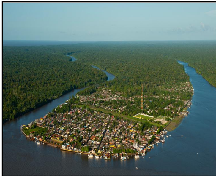
FOTO 03- CIDADE DE AFUÁ: localizada na Messoregião do Marajó, construída praticamente toda sob palafitas. (Foto retirada do blog: http://naduvidaexperimenta.blogspot.com.br/2012/11/paraisos-no-brasil-onde-carro-nao-entra.html ). Acesso: 10 de janeiro de 2014.
